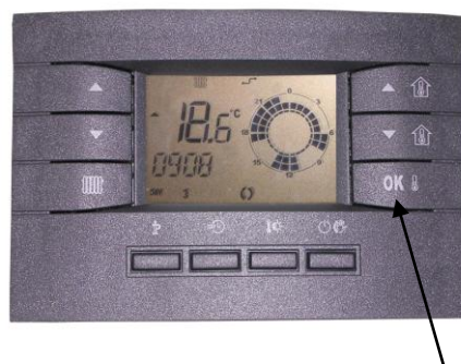
Rysunek 28 – Odblokowanie termostatu ograniczenia temperaturowego
